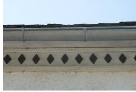
Corniche avec modénature de bois soignée, pour les habitations, comme pour les granges du plateau
